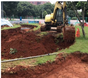
現場地坪開挖
